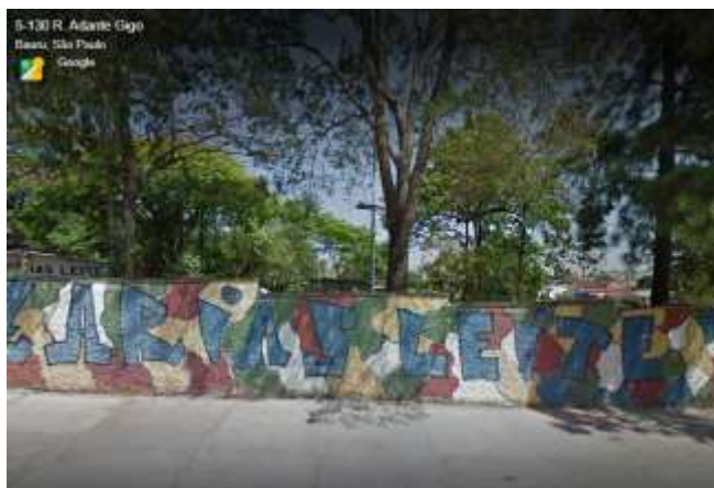
Figura 1: Fachada do muro da E. E. Azarias Leite – Bauru/SP. Fonte: A própria Autora.
