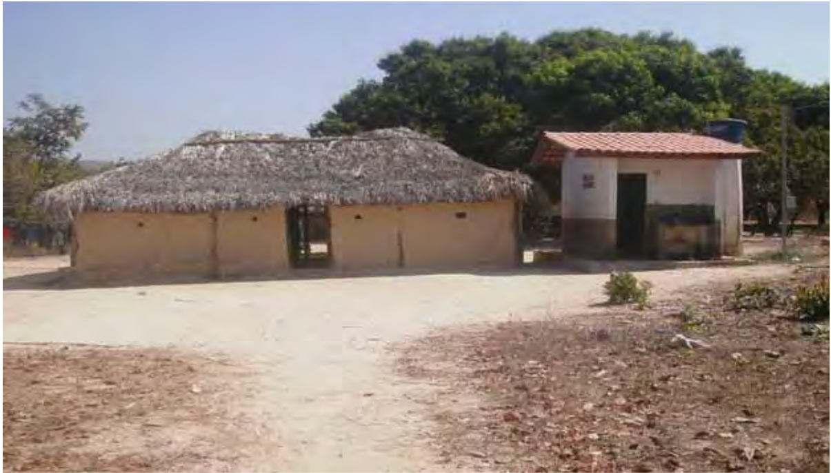
Fig. 6: Casa tradicional kalunga contrastando com edificação padrão de alvenaria.
