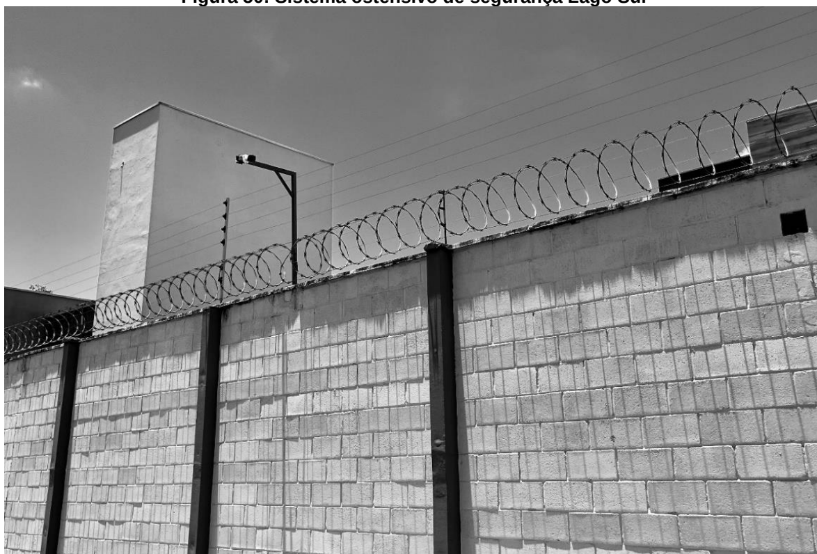
Figura 50: Sistema ostensivo de segurança Lago Sul
