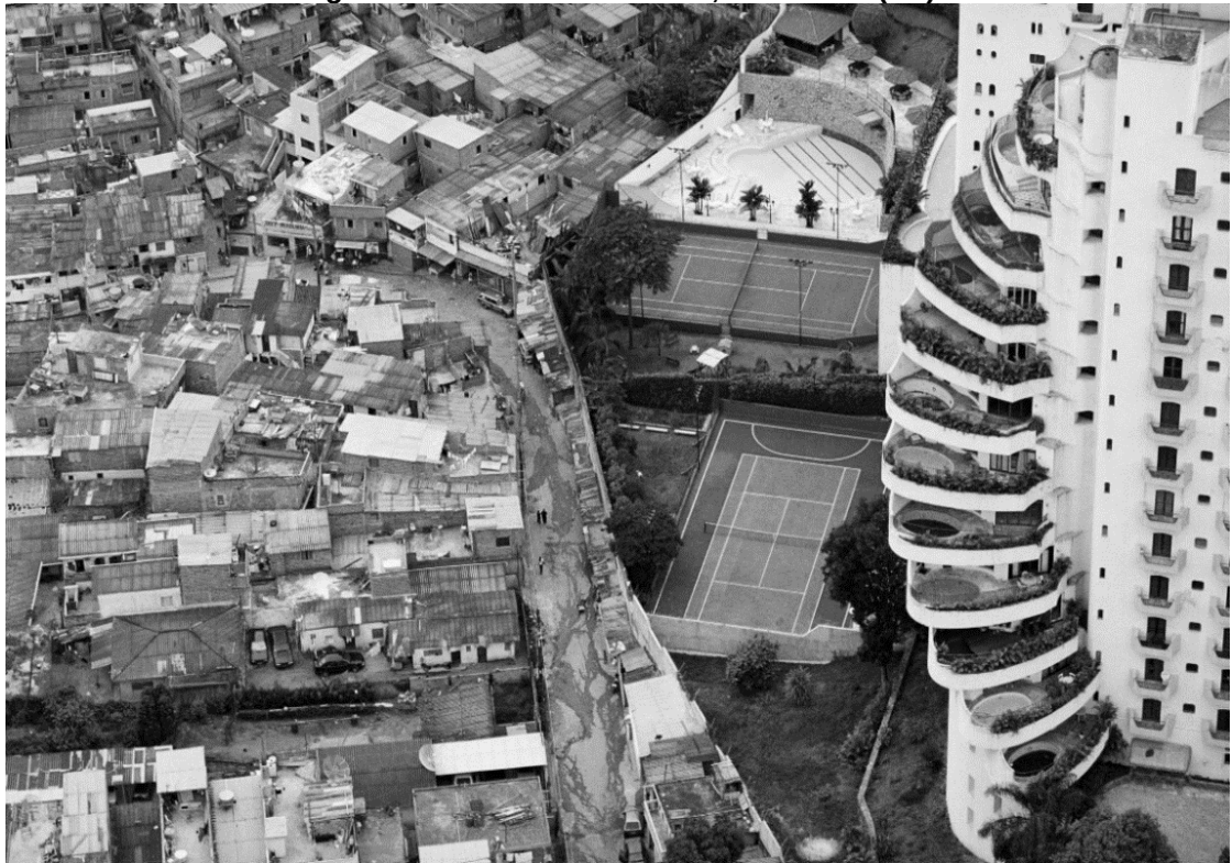
Figura 12: Edifício Penthouse, São Paulo (SP)
