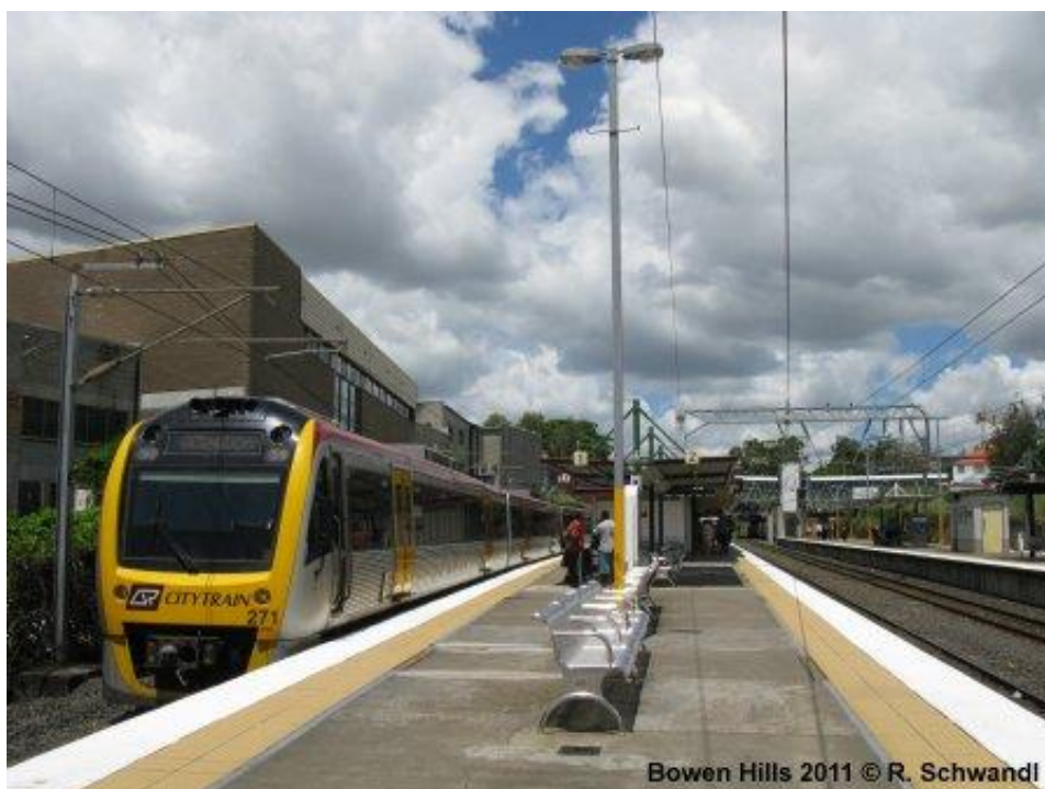
Fotografia 8 - Sistema de trem suburbano de Brisbane (Austrália)
