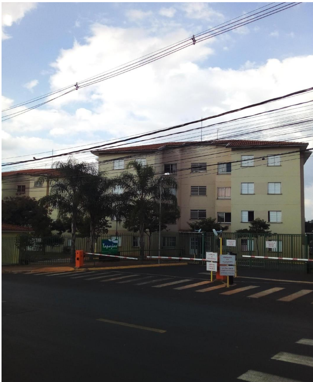
Foto 12 – Vista da Entrada do Conjunto Habitacional Residencial Tapajós (2022)
