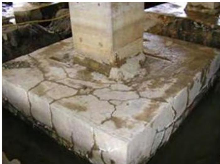
Figura 3 - Vista superior da fundação de um pilar sobre ação deletéria da RAA de um edifício da Região do Grande Recife – PE (PECCHIO et al., 2006)
