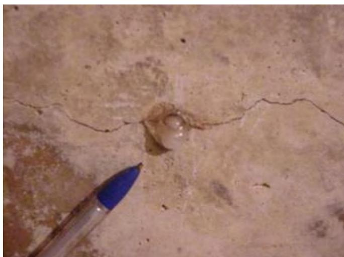
Figura 5 - Gel exsudado a partir de uma fissura na superfície de uma estrutura de concreto (HASPARYK et al., 2006)
