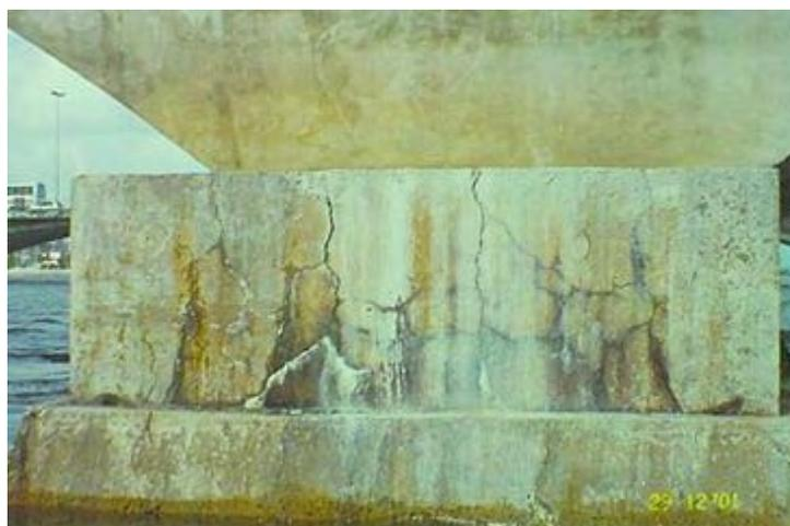
Figura 2 - Fissuras e trincas típicas de expansão, induzidas pela RAA em um dos blocos da Ponte Paulo Guerra em Recife – PE (ANDRADE, 2006)
