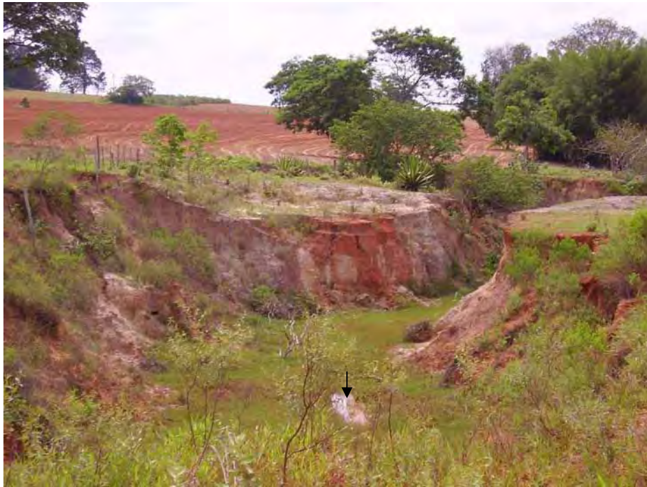
Fotografia 7 – Voçoroca com afloramento do lençol freático (seta) e área com solo revolvido para semeadura sob sistema convencional (alto curso, 2005)
