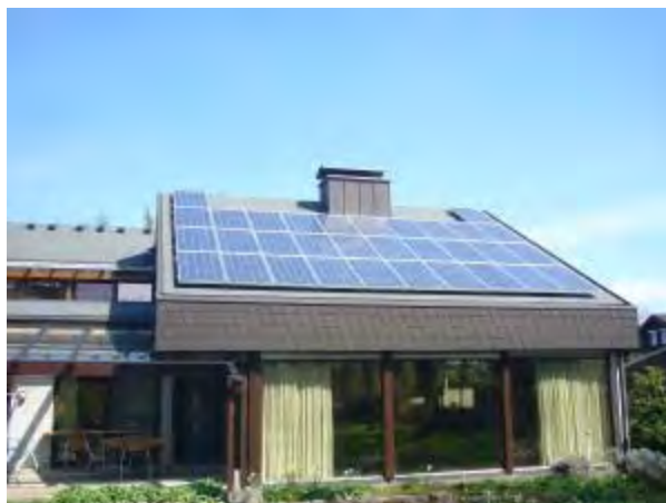
Figura 08 – Casa com potência instalada de 5.760 W (bs-solar.de)
