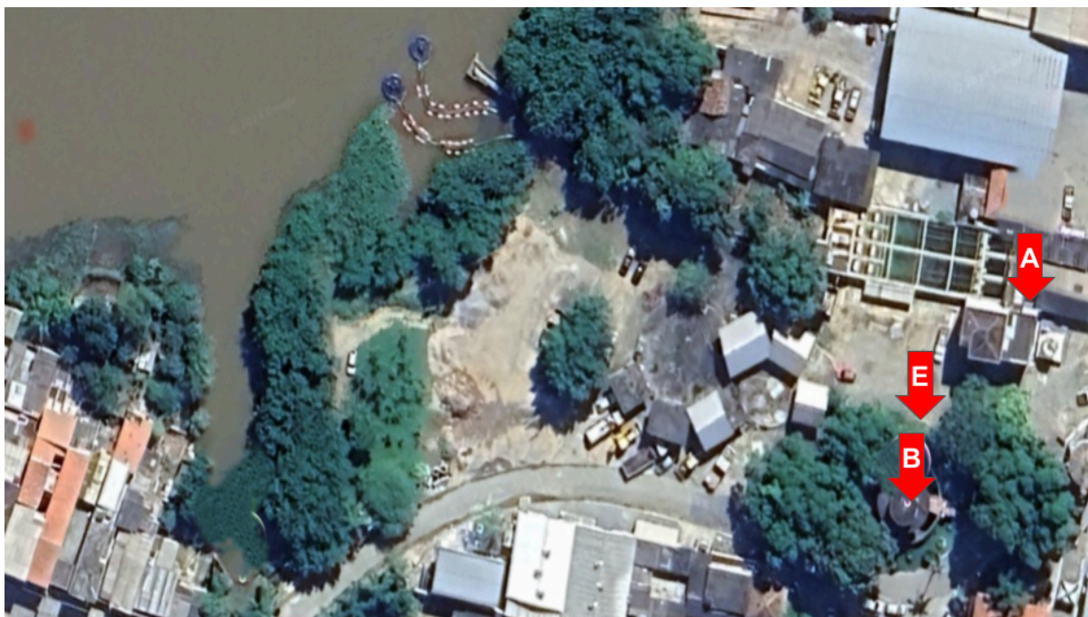
Figura 8 - Ponto de abastecimento de caminhão tanque de "ÁGUA NÃO POTÁVEL".
