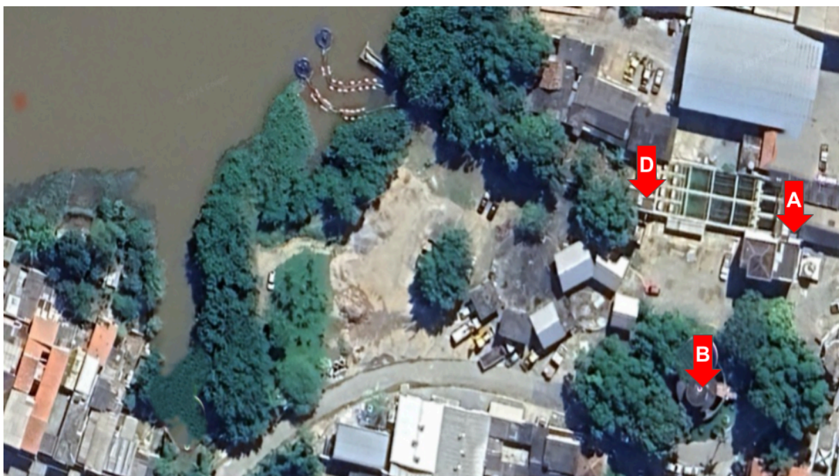
Figura 7 - Caixa de entrada de água bruta da ETA do SAAE Aparecida/SP.
