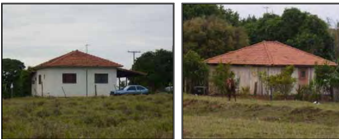
Figura 5: Moradia rural do Município de Indiana. (à esquerda: exemplo de casa de alvenaria; e, à direita: tipo de residência de madeira). Autor: R.A. Menegati (Nov/2005).
