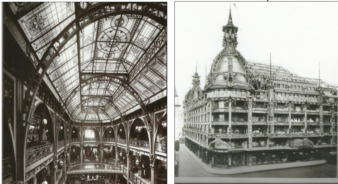
Figuras 5 e 6 – À esquerda, vitrais no teto da Au Printemps em Paris, permitindo a entrada de luz natural e à direita a fachada da Samaritaine em Paris com uma torre e paredes de vidro
