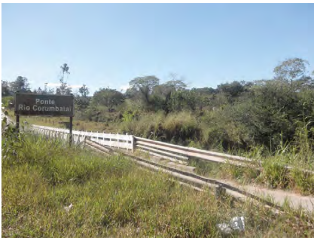
Figura 13 – Ponte sobre o Rio Corumbataí que liga os bairros Jardim Novo Wenzel e Jardim Bonsucesso com o resto da cidade
