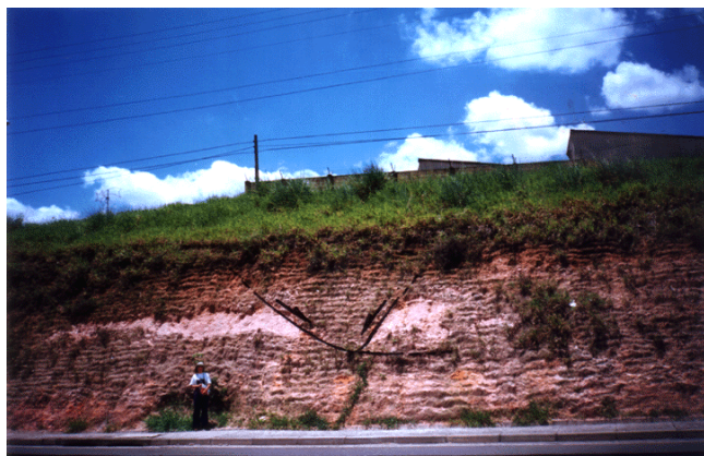
Foto 6.4 (a): Camada de argilito dos depósitos terciários afetada por falhas normais (ponto 3).
