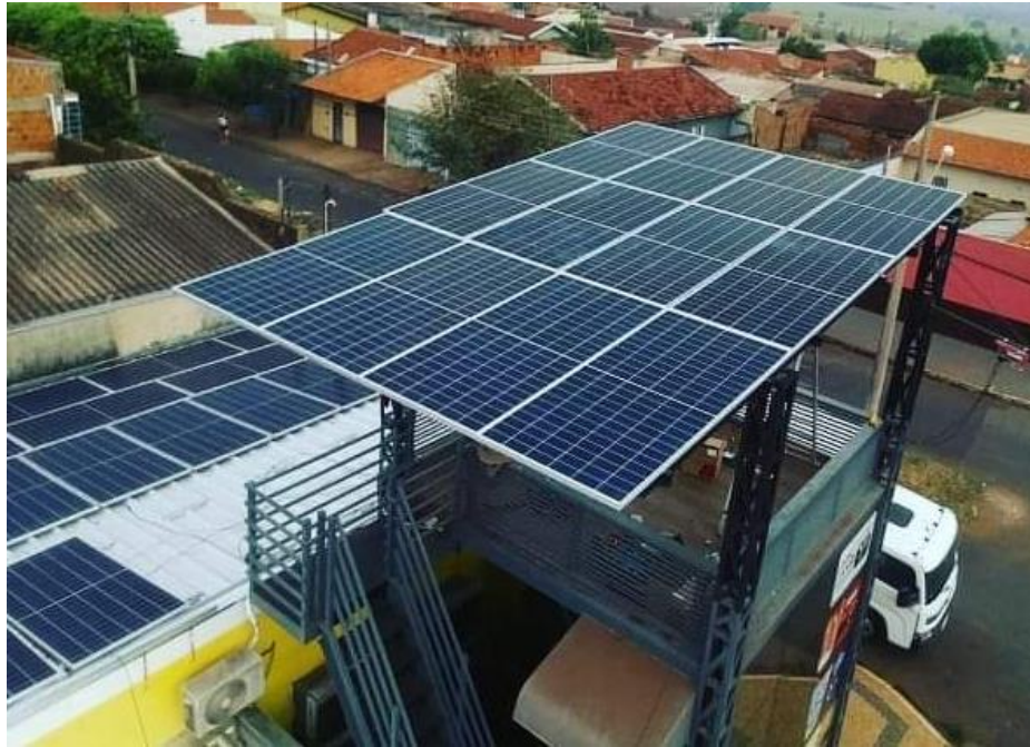
Figura 43 – Instalação dos painéis sobre plataforma adicional de placas.
