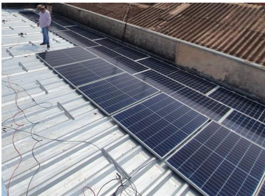
Figura 41 – Instalação dos Painéis sobre telhado inclinado.
