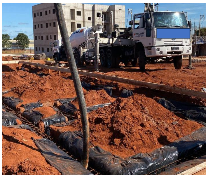
Figura 15: Concretagem do baldrame.
