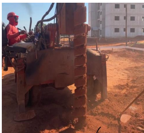
Figura 12: Escavação das estacas.
