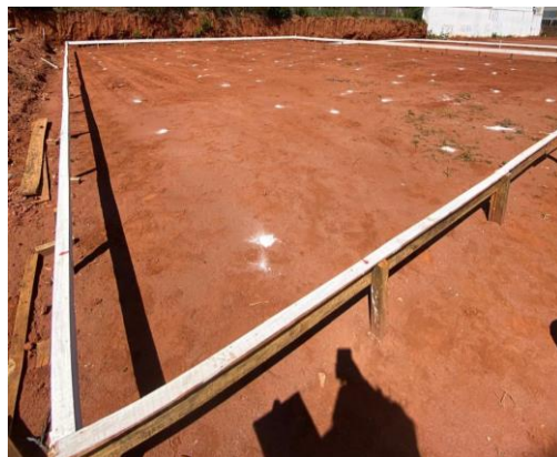
Figura 11: Marcação das estacas.
