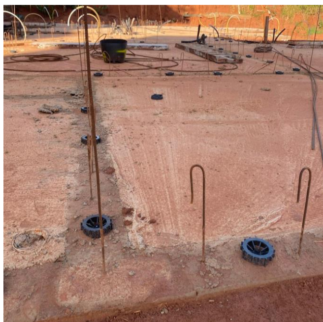
Figura 17: Marcação do piso.
