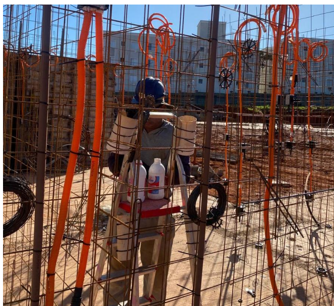
Figura 19: DMA armação e instalações das paredes.
