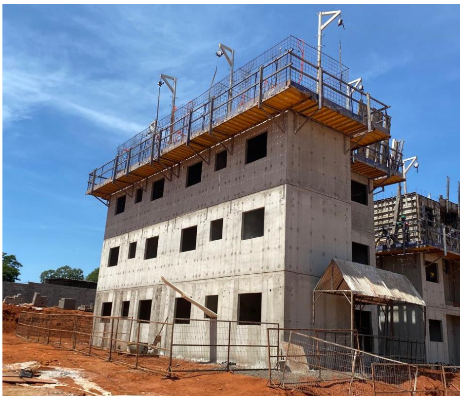
Figura 29: Estrutura recém desformada.
