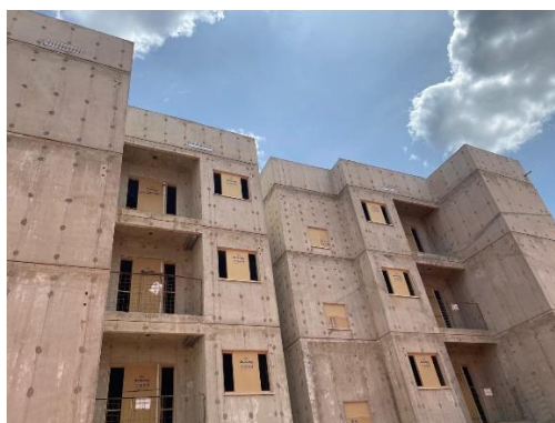
Figura 10: Foto de um dos blocos já concretados.
