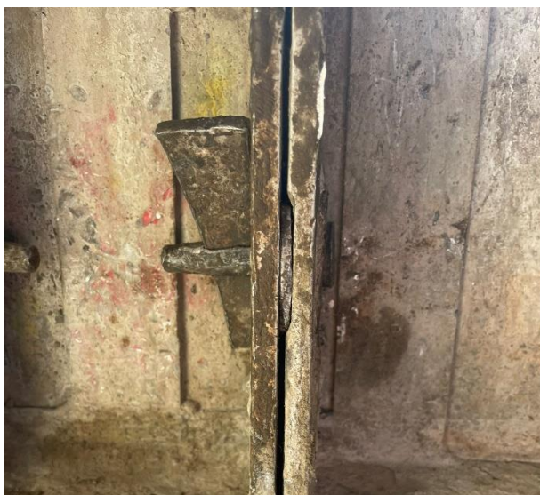
Figura 2: Dispositivo de união: faqueta, pino e cunha.
