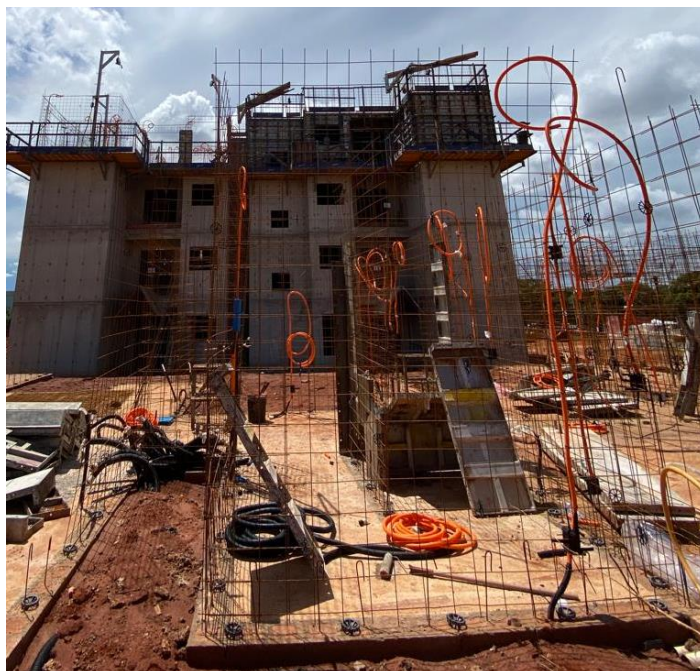
Figura 3: Armação de paredes.
