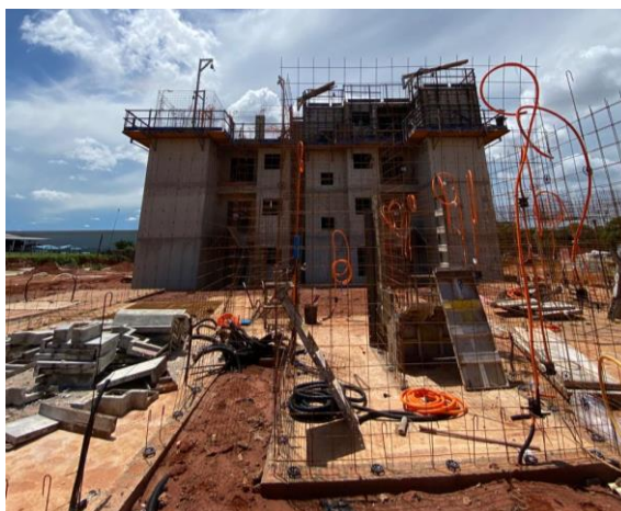
Figura 1 - Edifício de paredes de concreto sendo construído
