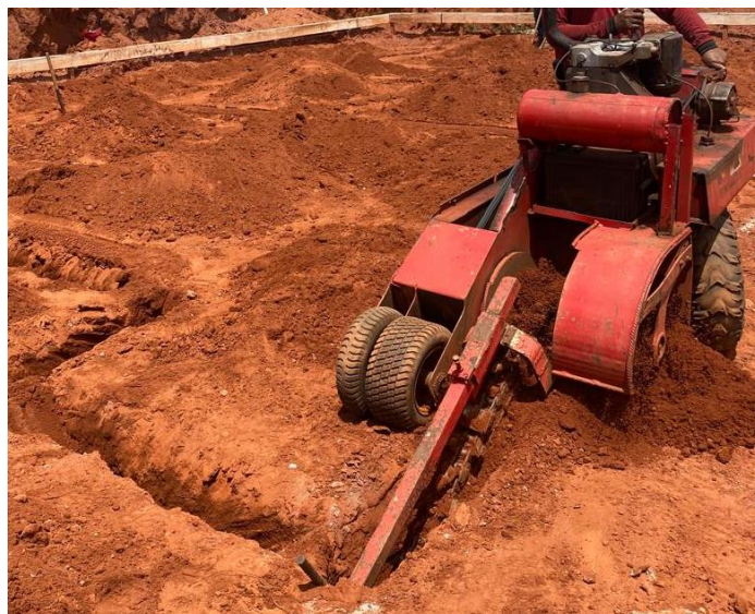
Figura 14: Escavação do baldrame.
