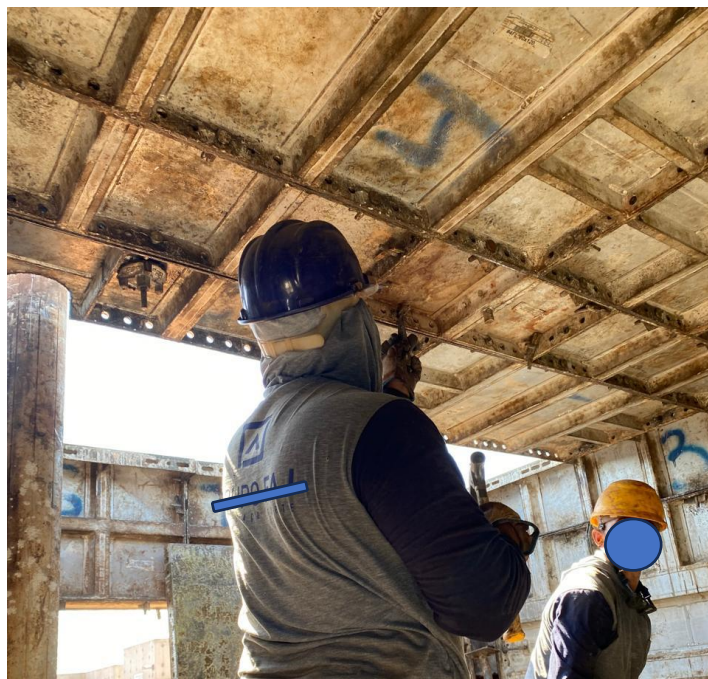
Figura 22: Montagem da fôrma.
