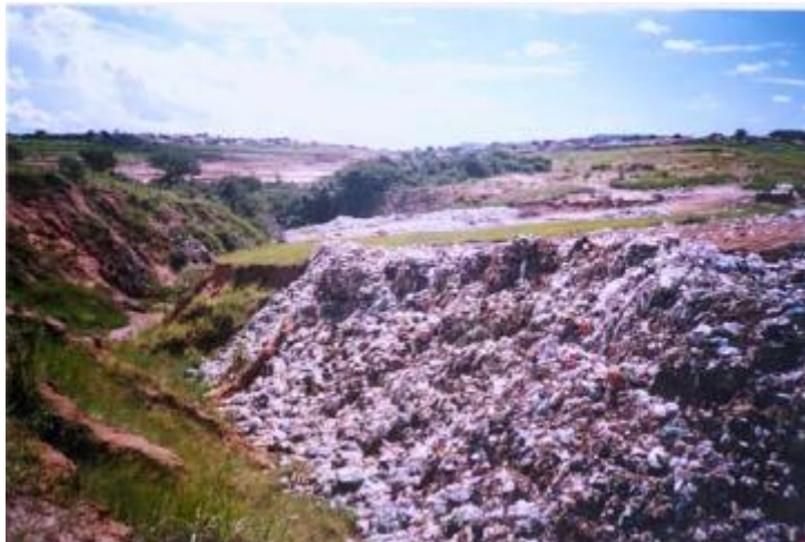
Figura 36 - Feição erosiva D no ano de 2002 sendo utilizada como depósito de resíduos.
