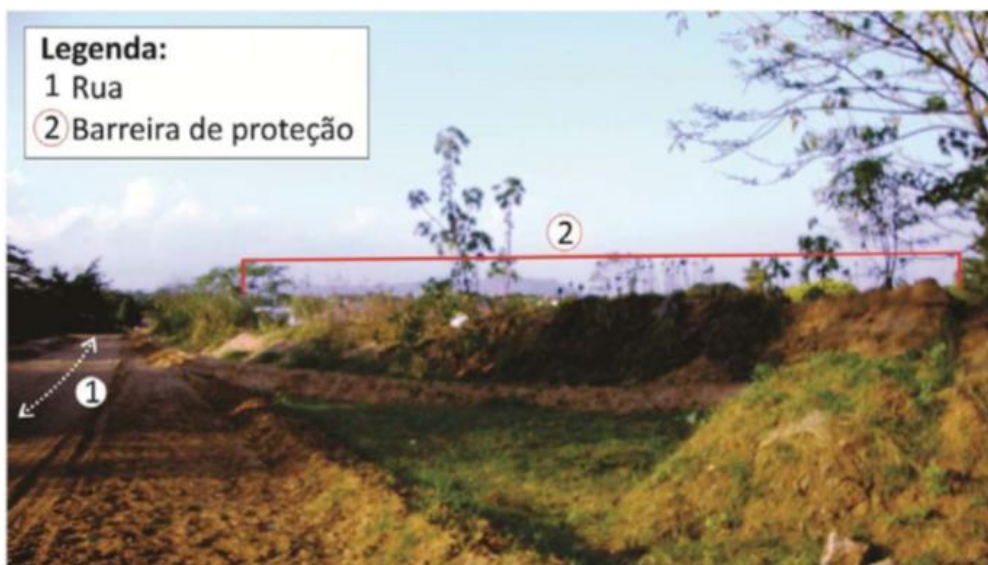
Figura 52 - Barreira de proteção construída com o solo do local ao redor das feições erosivas a fim de conter sua evolução.
