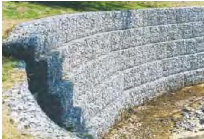
Figura 74 - Gabiões em caixa dispostos em anfiteatro.
