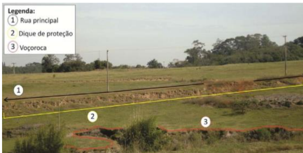
Figura 42 - Dique construído a partir de solo movimentado paralelo a rua.
