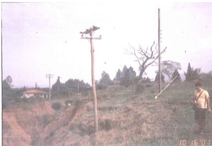
Figura 26 - Presença de residência e linhas de transmissão em voçorocas.
