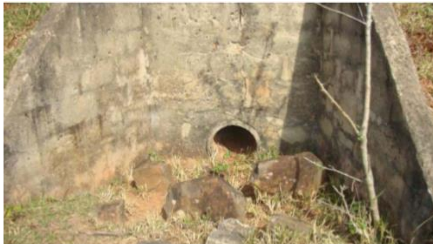
Figura 44 - Blocos de rocha nas saídas das tubulações a fim de evitar o surgimento de novos processos.
