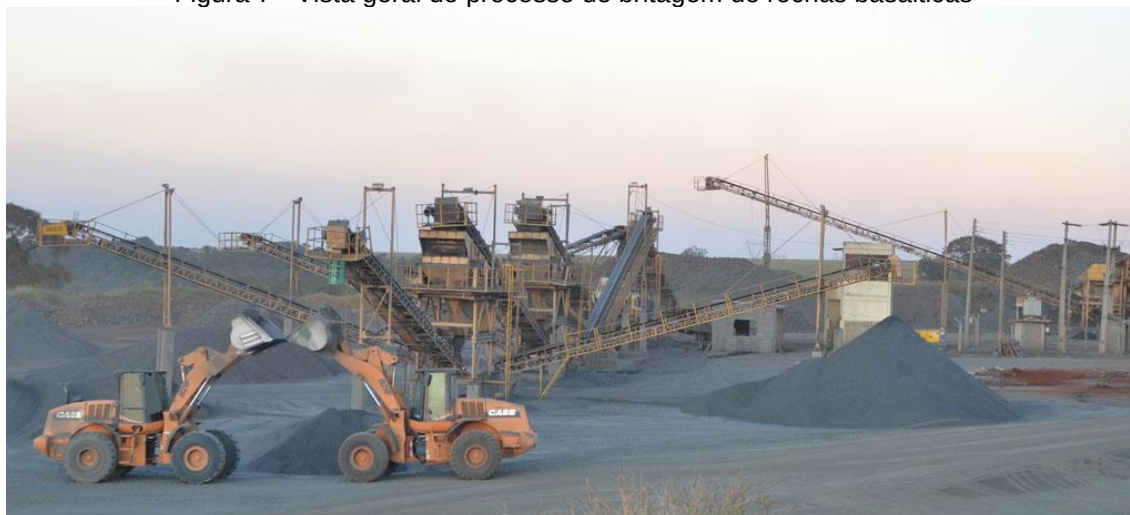
Figura 7 - Vista geral do processo de britagem de rochas basálticas
