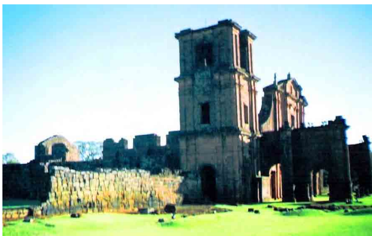
Ilustração 1: Vista lateral dos remanescentes da Redução de São Miguel das Missões/RS. Construção setecentista Jesuítico-Guarani.
