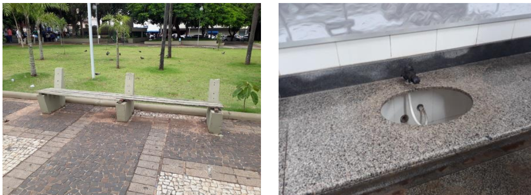
Figuras 30 e 31: Bancos, louças e metais de banheiro quebrados.
