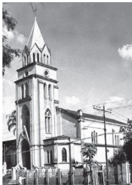
Igreja neogótica de demolida em 1955 por apresentar muitas rachaduras https://br.pinterest.com/pin/660481101609489529/
