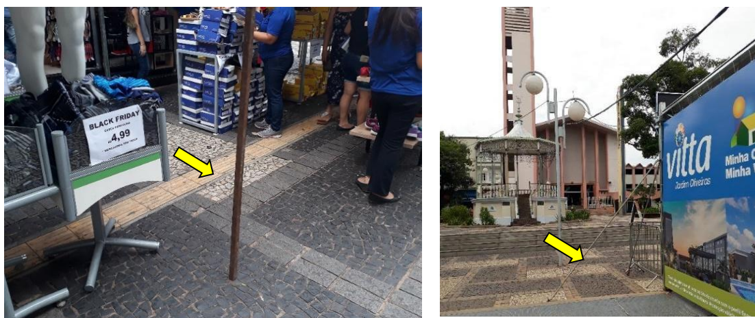
Figuras 28 e 29: Faixa de piso tátil obstruída por produtos do comércio em exposição; cabo de aço estendido, não detectável, usado para fixação de estande de vendas.
