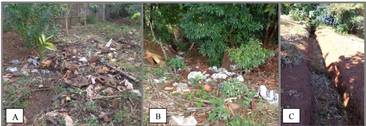
Figura 25 - A) Lixo e entulho depositados incorretamente próximo à vala; B) Vala de escoamento Fotografias da autora, 2015.
