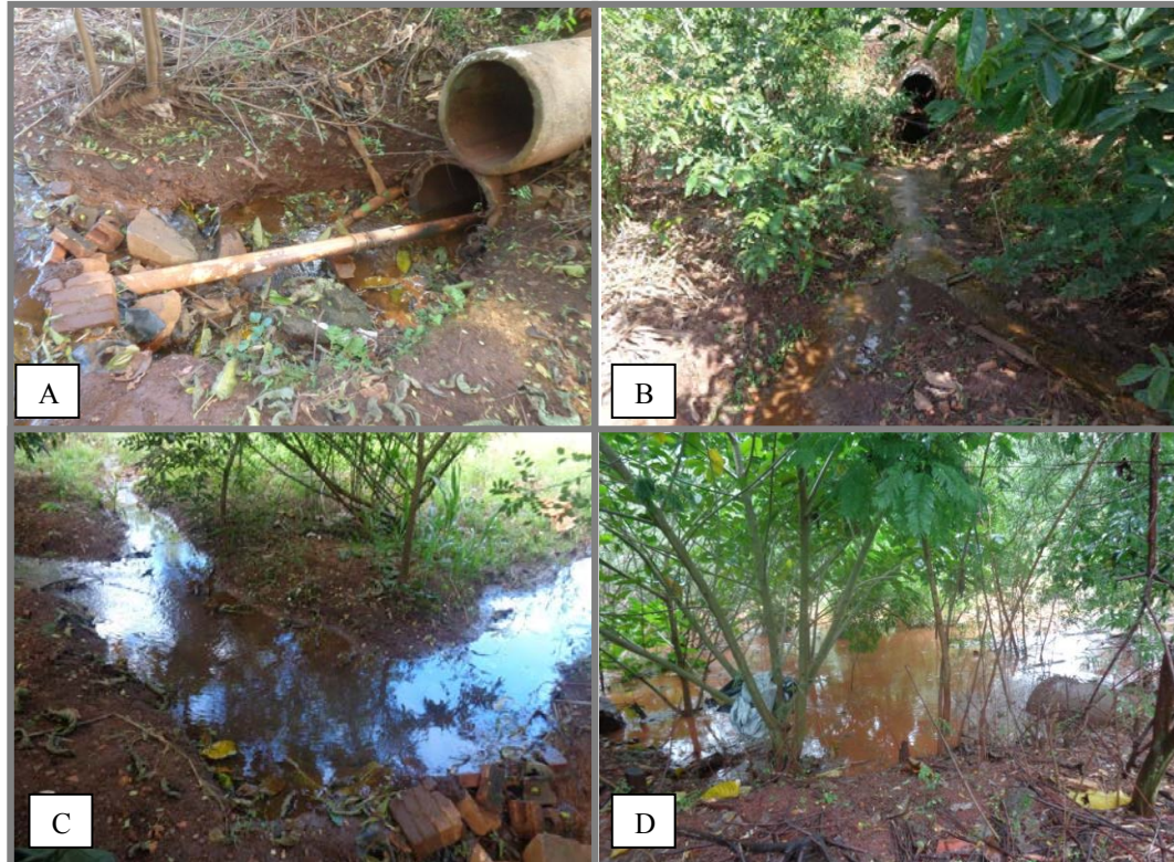
Figura 28 - A) Emissários (tubulações) para seguem as águas das nascentes. B) Vazão durante estações secas; C) Vazão durante estações chuvosas; D) Área alagada durante fortes chuvas (foto dia 28/12/2015).
