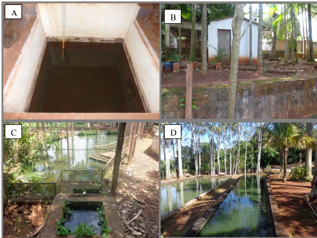
Figura 19 - A) Reservatório de concreto; B) Proteção do reservatório (casinha); C) Vazão externa e piscina de peixes ornamentais; D) Tanques de criação de peixes Fotografia da autora, 2015.
