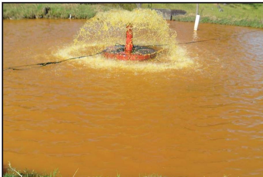
Figura 06: Vista parcial da segunda Lagoa de Estabilização, evidenciando a entrada do efluente, com movimentação superficial, facilitando a dissolução de oxigênio atmosférico. Foto: Junho /2011.
