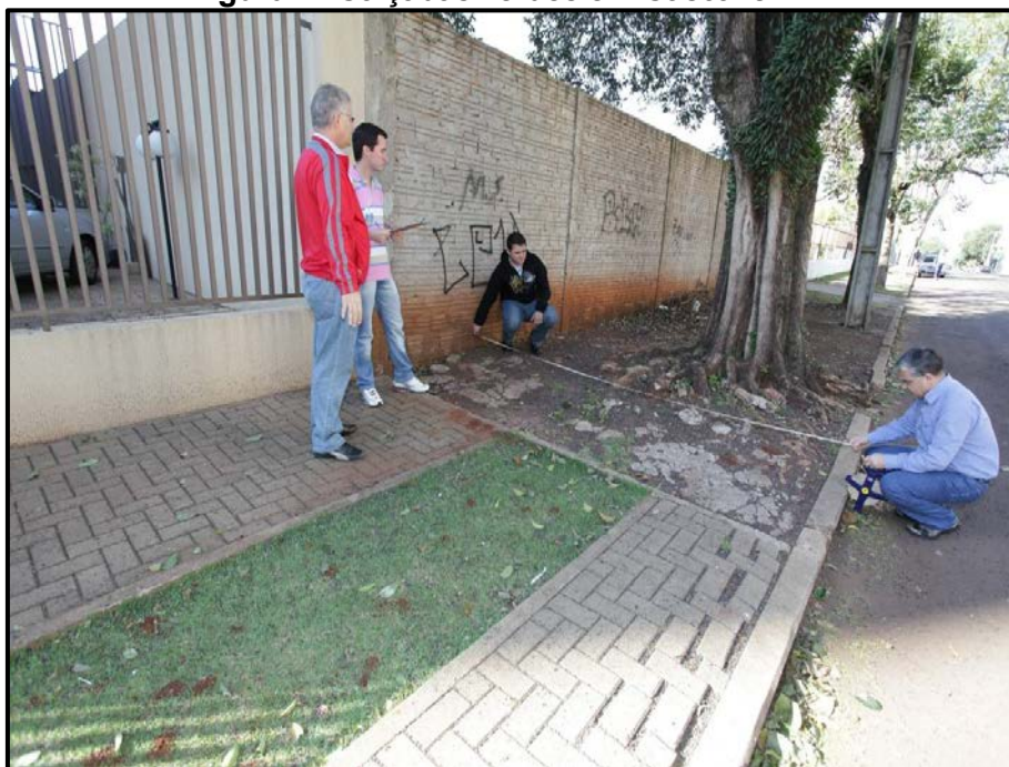
Figura 7: Calçadas verdes em Cascavel/PR.
