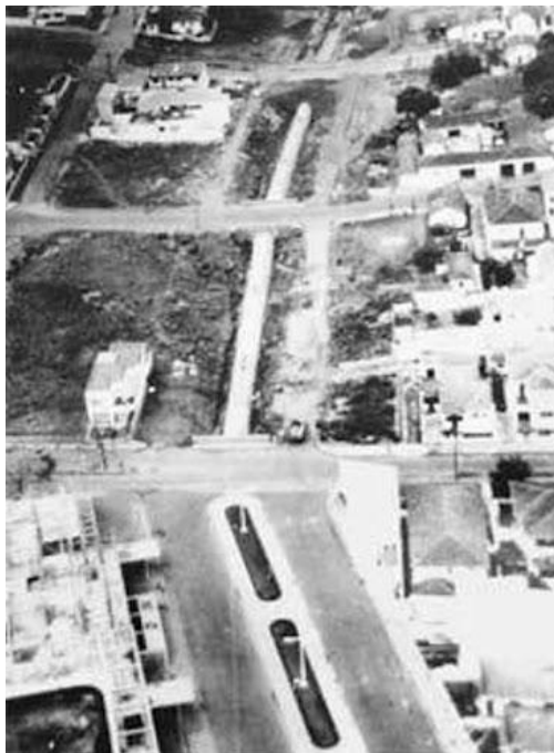
Figura 6 – Canalização do Córrego Canela na Avenida Alberto Andaló em frente ao Automóvel Clube
