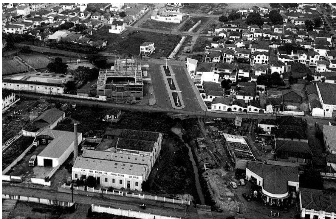
Figura 7 – Avenida Alberto Andaló em Construção Sobre o Córrego Canela
