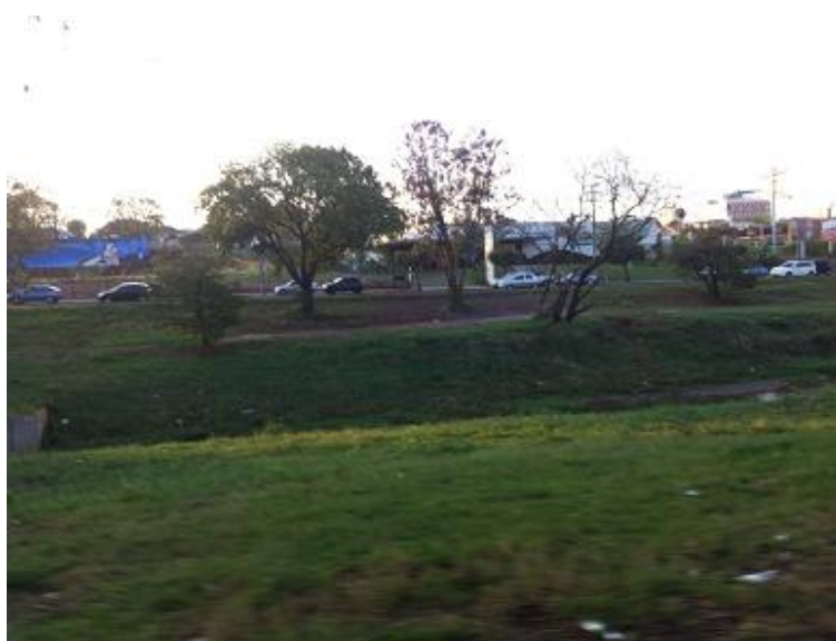
Figura 11 - Ausência de Mata Ciliar no Córrego Borá na Continuação da Avenida Bady Bassitt
