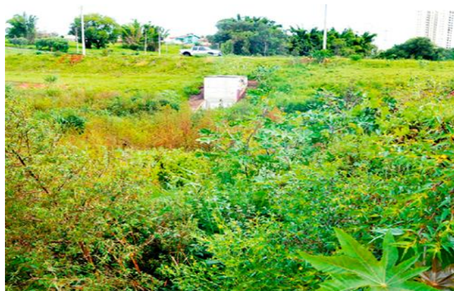
Figura 25 - Piscinão coberto de mato próximo à Avenida Bady Bassitt
