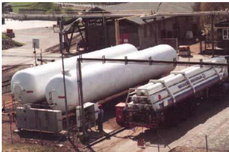
Figura 9 - Cilindros do tipo I aplicado no armazenamento estacionário.
