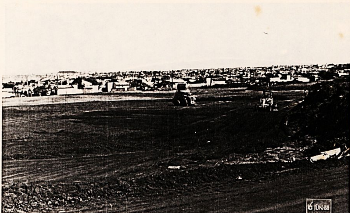
Preparação do terreno para início das construções das residências do Núcleo (junho/1988). Foto cedida pela COHAB - Bauru.
