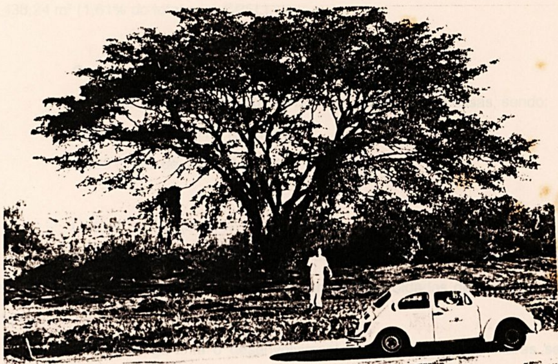
Ponto central do futuro Núcleo Mary Dota, quando na preparação do terreno para início das construções (maio/1988). Vê-se ao fundo, vista parcial do centro da cidade de Bauru. Foto cedida pela COHAB - Bauru.
