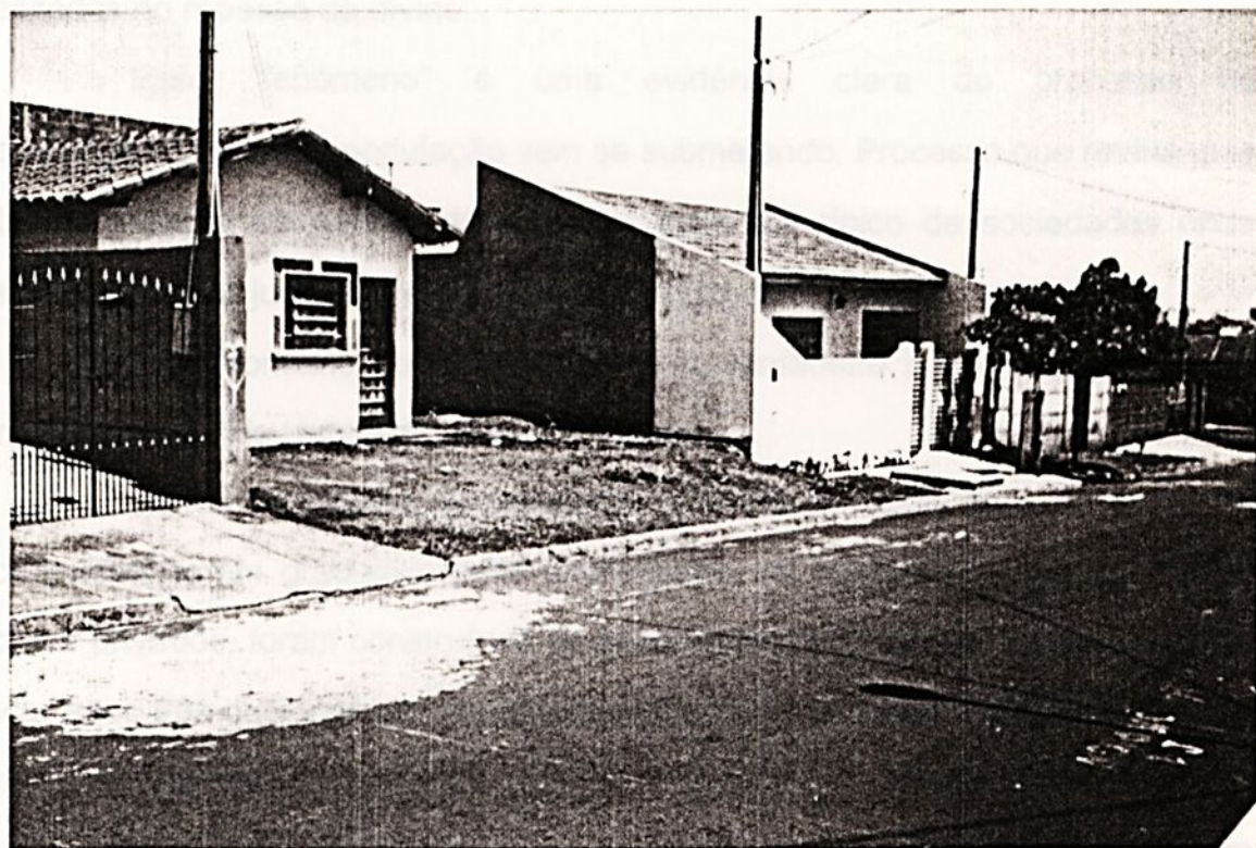
A descaracterização arquitetônica das residências são evidentes em qualquer parte do Núcleo (junho/1993). Foto de Edward G. Jr.
