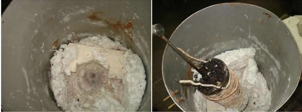
Figura 10 – a) e b) Retirada da lã de rocha do vaporizador.
