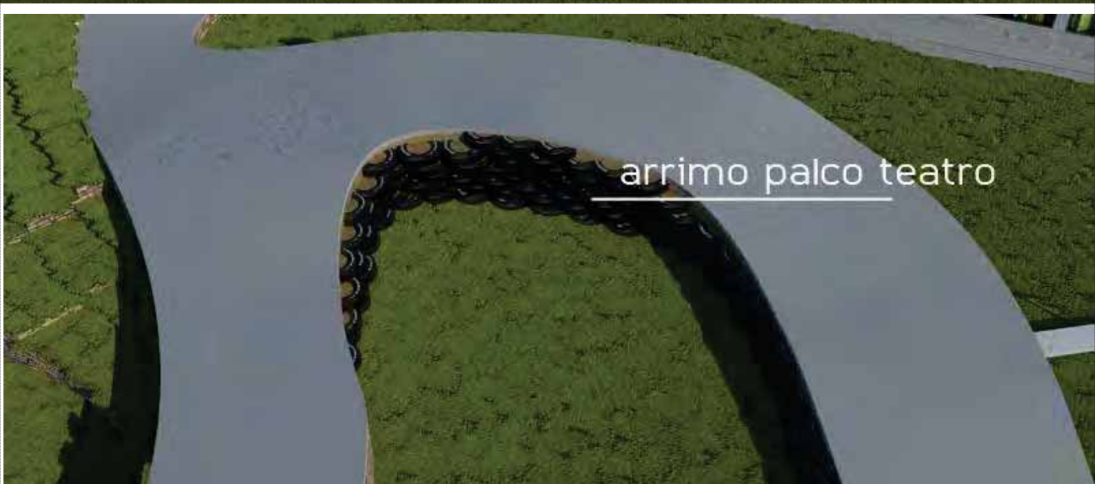
Figuras 98 e 99 – Muros de arrimo de pneu Fonte: da autora (2011).
