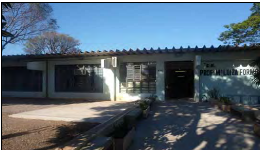
Figura 47 – Fachada norte da E.E. Maria Luiza Formozinho Ribeiro Org. Simone Scatolon Menotti Viana
