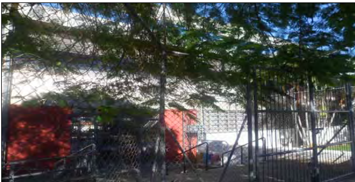
Figura 71 – Vista da Fachada norte da E.E. Hugo Miele Org. Simone Scatolon Menotti Viana
