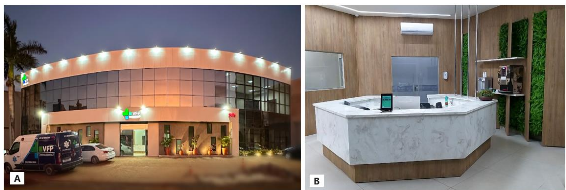
Figura 12. Estrutura do Hospital Veterinário Vet for Pet (VFP). A. Estrutura externa da VFP. B. Recepção da VFP. Fonte: < https://vfphospital.com.br/ >.
