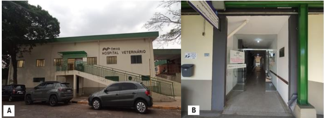
Figura 1. Estrutura da Unesp FMVZ. A. Entrada do Hospital Veterinário e recepção. B. Entrada para o atendimento dos ambulatórios e preparo cirúrgico. Fonte: acervo pessoal.
