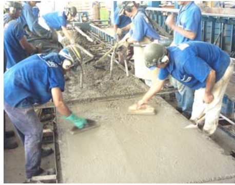
Figura 4.4 - Etapa de adensamento e regularização da superfície
