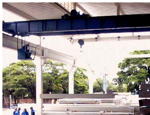
Figura 4.8 - Içamento de uma viga em concreto pré-moldado
