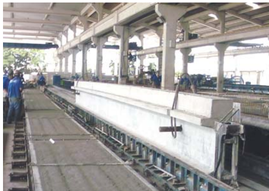
Figura 4.7 - Aspecto de uma viga desmoldada
