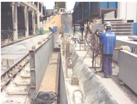
Figura 4.2 - Preparação de uma fôrma
