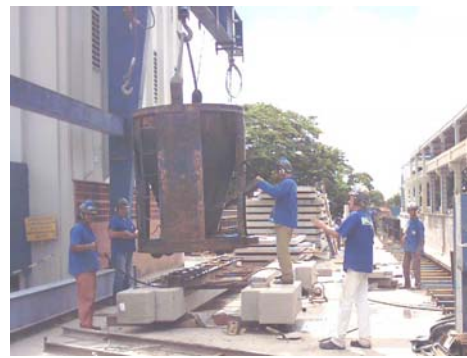
Figura 4.3 - Deposição do concreto na fôrma
