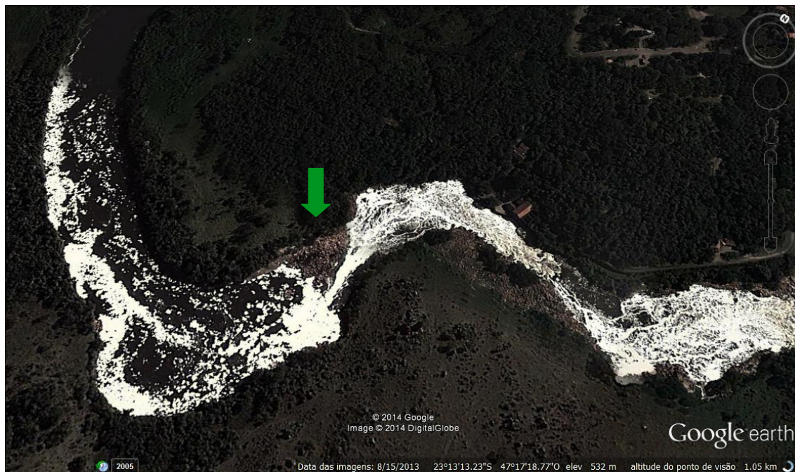
Figura 27: Margem com enrocamento no rio Tietê, próximo a cidade de Salto – SP.
