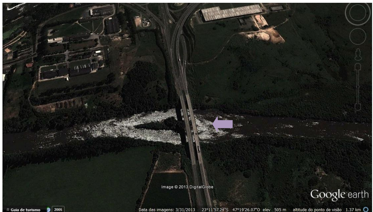
Figura 23: Ponte no rio Tietê, próximo à cidade de Itu – SP.
