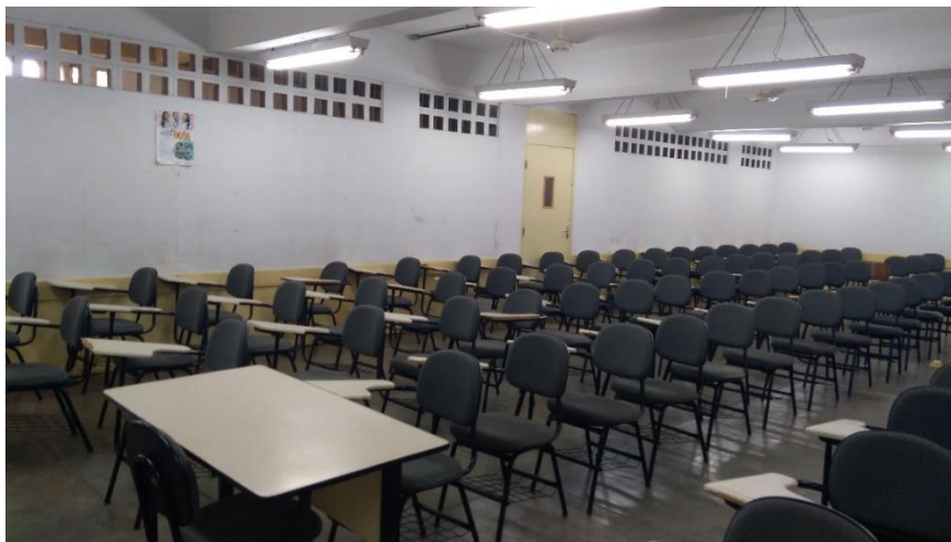
Figura 8 - Aspectos da sala de aula: tijolos vazados.
