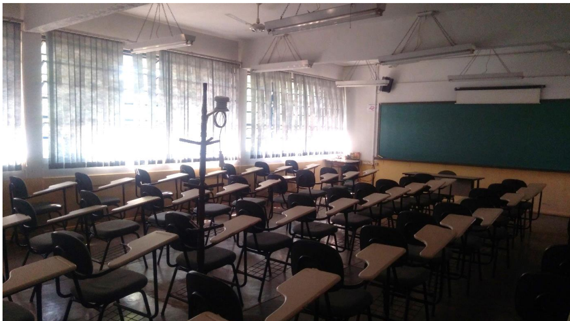
Figura 5 - Instalação de miniestação automática em sala de aula
