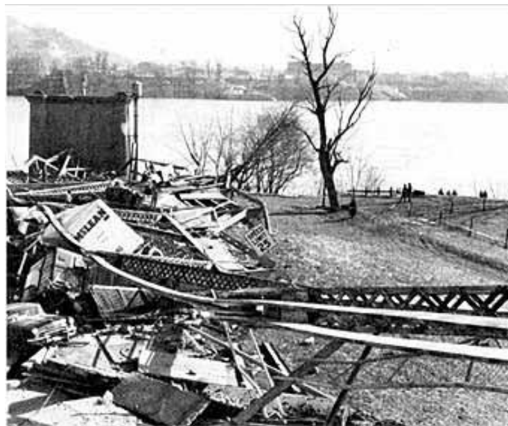
Figura 23 – Resultado final da falha da ponte “Pointe Pleasant” ocorrida em 1967 em Ohio- Estados Unidos.
