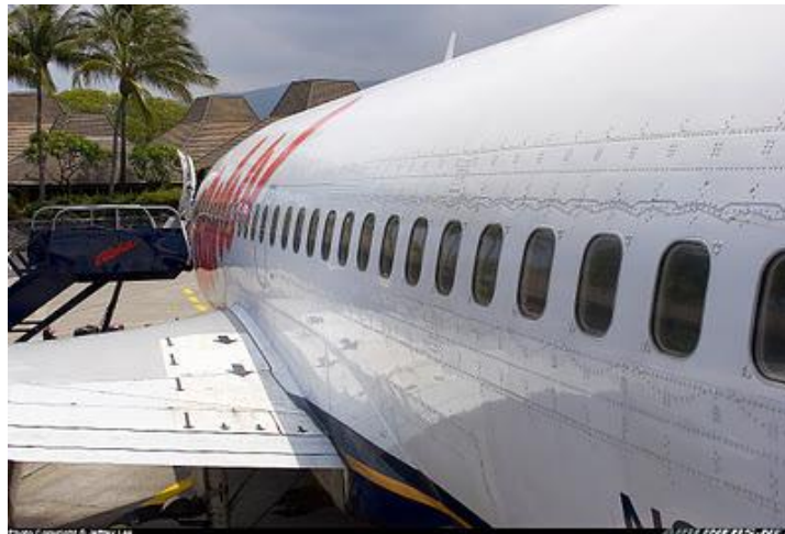
Figura 22 – Linhas das janelas reforçada por chapas sobrepostas em um Boeing 737.
