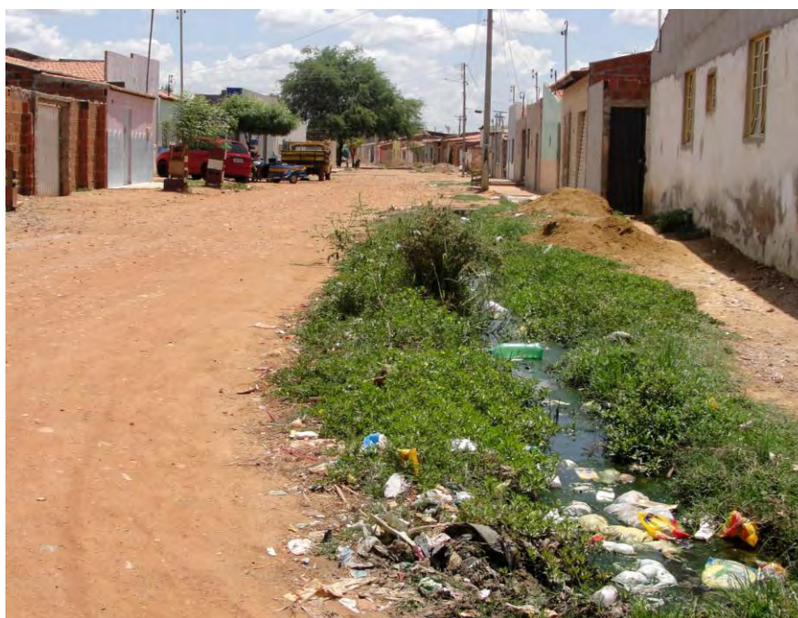
Figura 13. Ilustração de uma rua não pavimentada, com presença de lixo e esgoto a céu aberto, localizada no bairro Padre Vicente, município de Juazeiro – BA. (Jaboticabal – SP, 2013).
