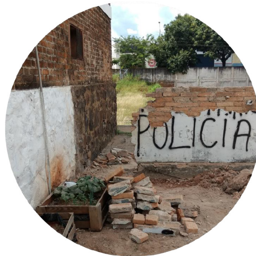
Figura 22: Pedaco do muro derrubado ao lado do Galpão da Lua, servindo de passagem. Fonte: CHAPARIM, 2018.
