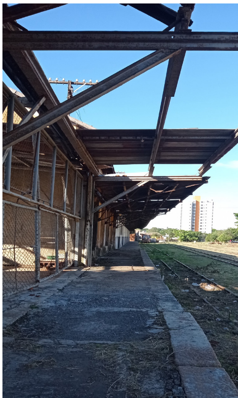
Figura 6: Trecho da cobertura dos Galpões na proximidade dos trilhos. Fonte: Autora, 2021.
