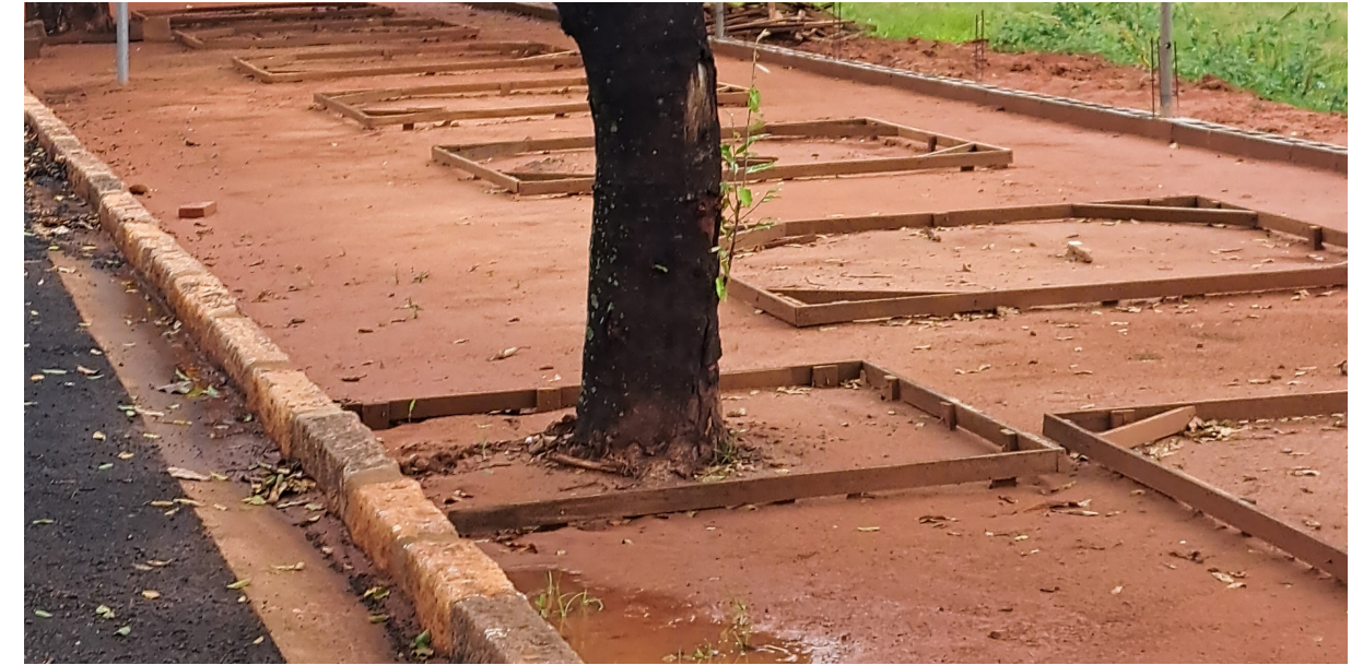
Figura 41: Fim da calçada em construção. Arquivo pessoal da autora, 2023.
