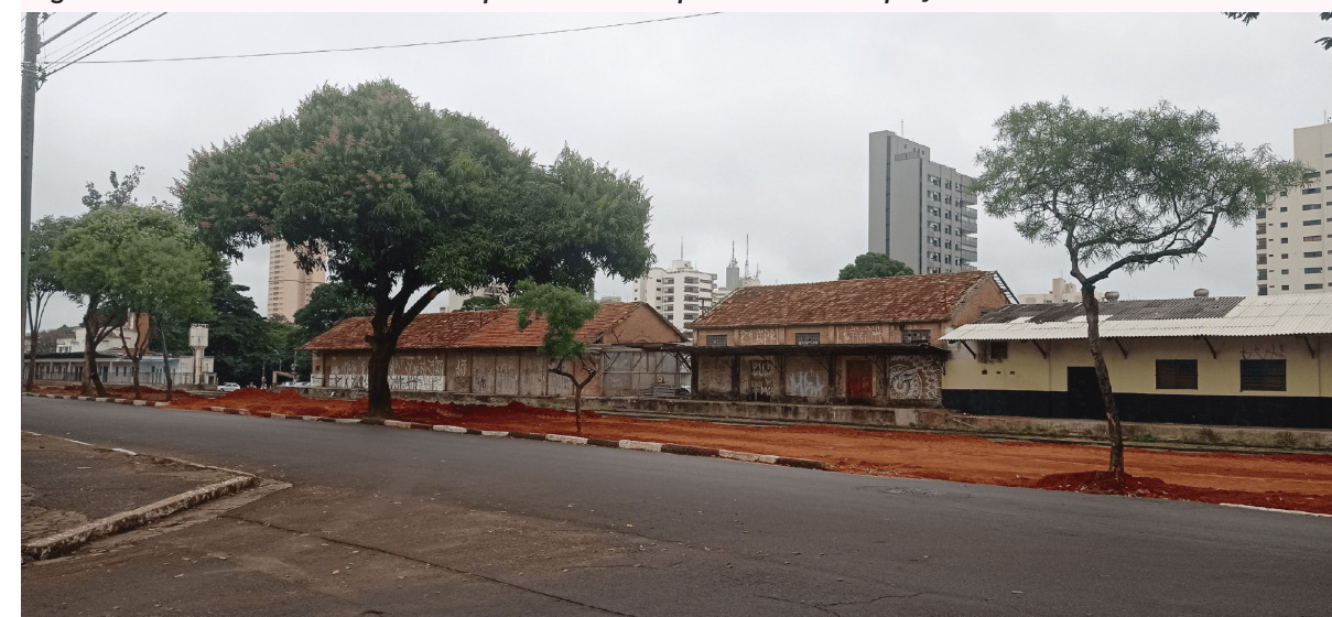
Figura 8: Trecho da linha sem o muro. Fonte: Autora, 2022.
