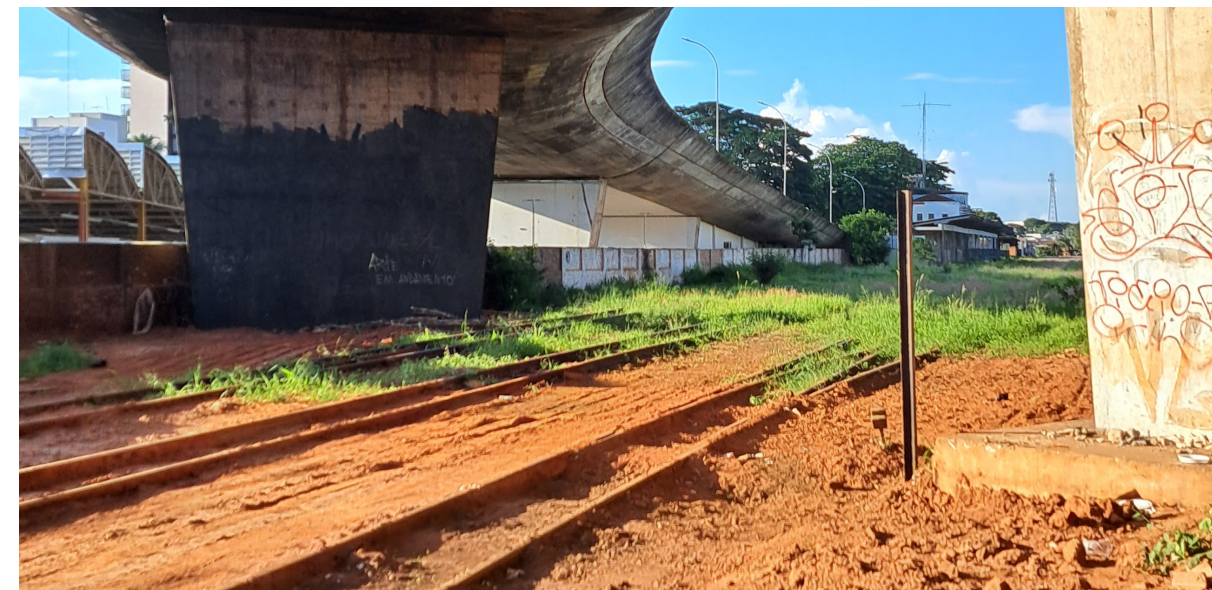
Figura 26: Vista da área sob o viaduto atualmente. Fonte: Autora, 2023.
