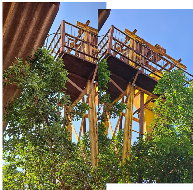
Figura 37: Posto de manutenção para trens, desativado. Fonte: autora, 2023.
