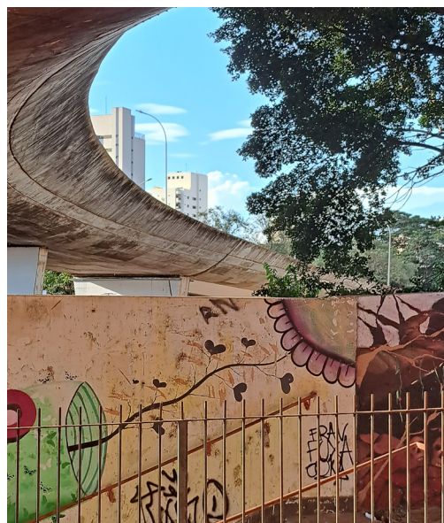
Figura 25: Vista lateral da passagem subterrânea sob os trilho. Fonte: Autora, 2023.
