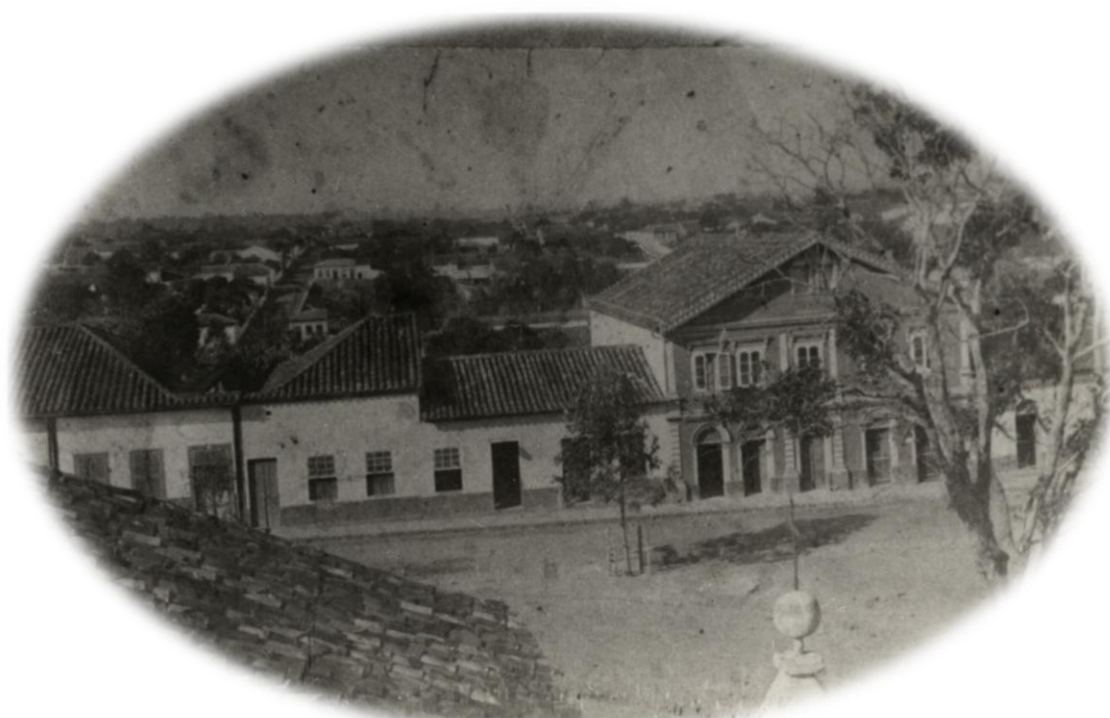
FIGURA 12 - Armazém Afonso Inforzato, Rua 8 com avenidas 10 e 12.
