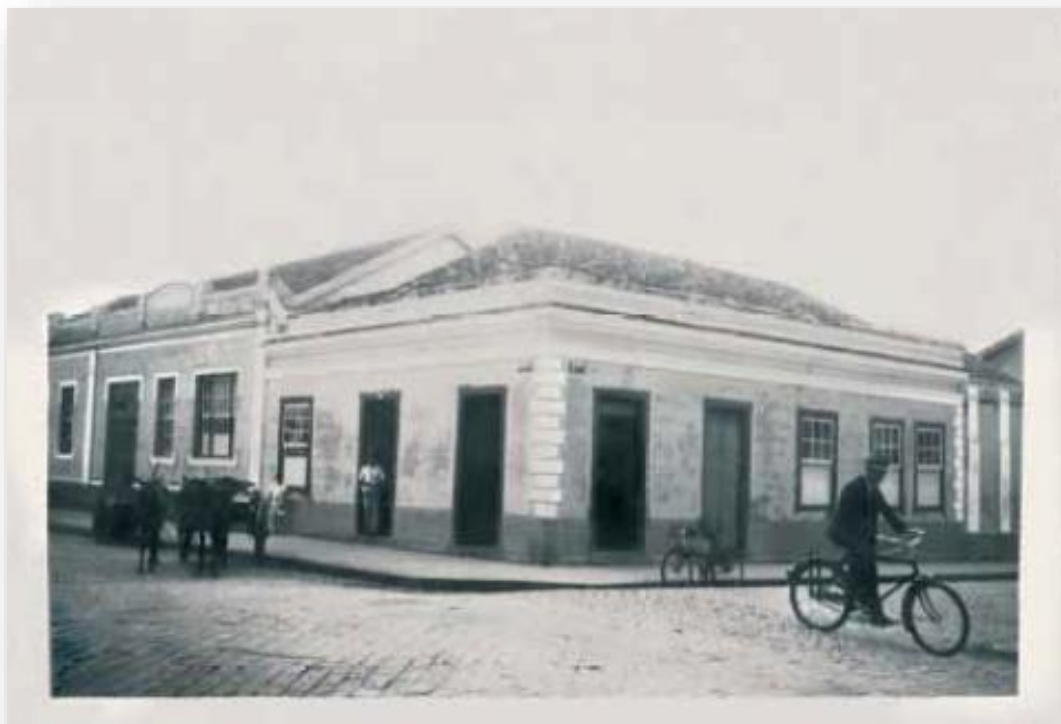
FIGURA 38 - Prédio original da antiga selaria e fábrica de chinelos Timoni, na rua 1, esquina da av. 6. Data da foto: 1944. Fonte: Acervo Pessoal de Sergio Luiz Timoni Rodini.
