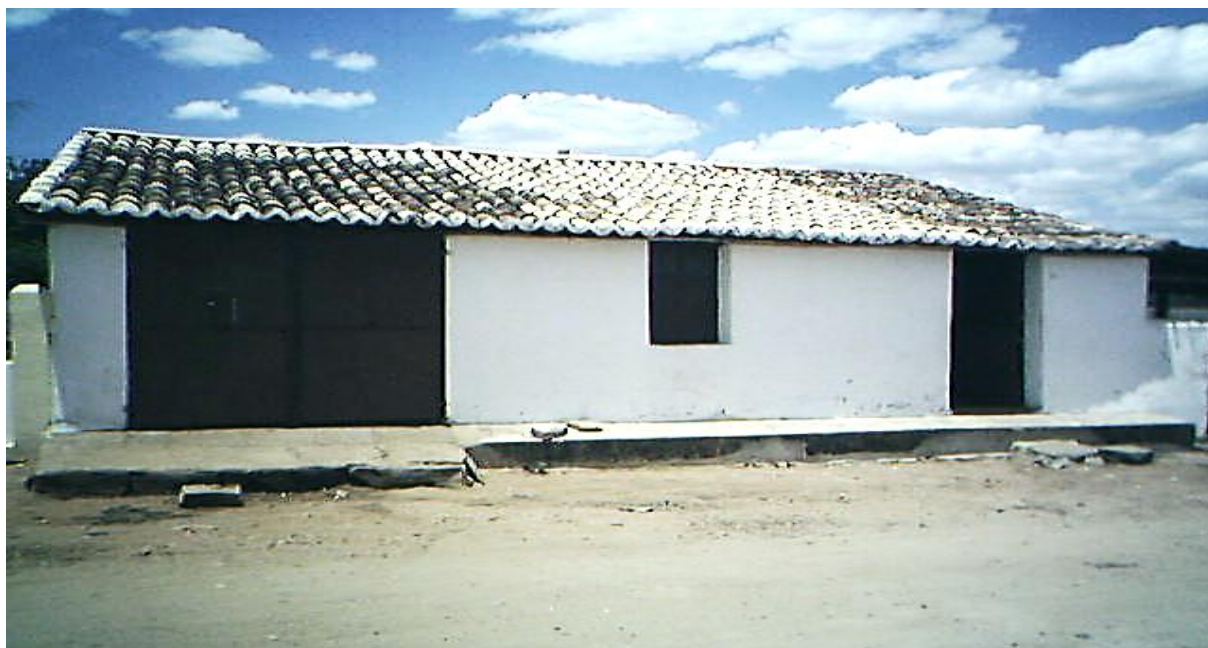
Figura 38 – Foto da casa de farinha na comunidade de Cajazeiras
