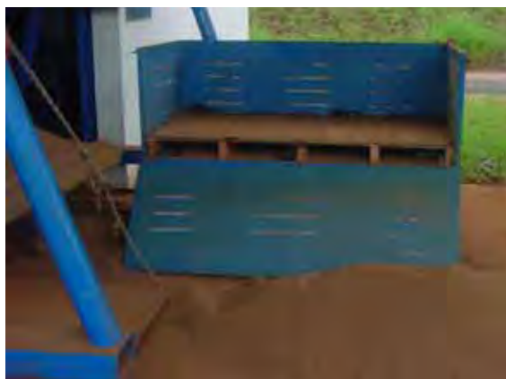
Figura 19. Solo descarregado do tanque.
