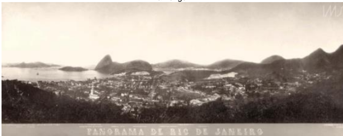
Figura 1. Bairros do Rio de Janeiro em 1880, incluindo Flamengo.
