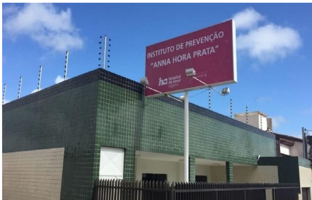
Figura 47: Unidade de Prevenção de Lagarto/SE
