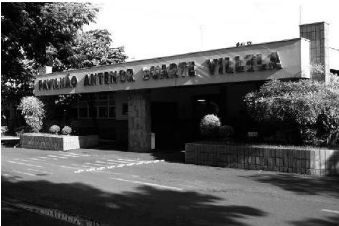
Figura 11: Ambulatório Pavilhão -Antenor Duarte Vilelall na Fundação Pio XII
