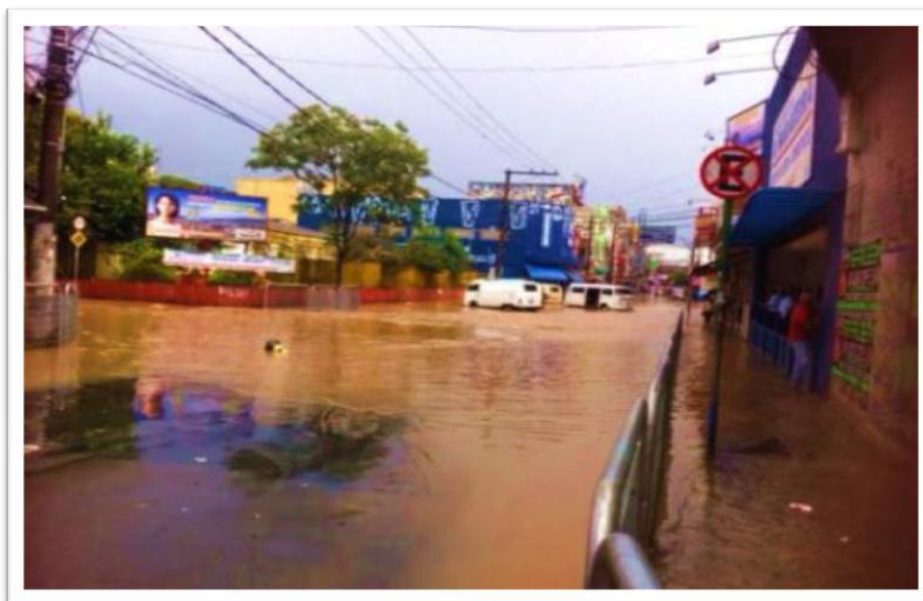
Foto 47. Avenida Cesário de Abreu e Rua Manoel Mendes em Itapevi.
