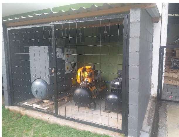
Figura 22 - Local de instalação
