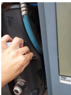
Figura 7 - Posicionamento do eletrodo
