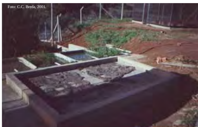
Figura 6: Terreiro de alvenaria utilizado para a deposição e secagem inicial do lodo de esgoto gerado na ETL.
