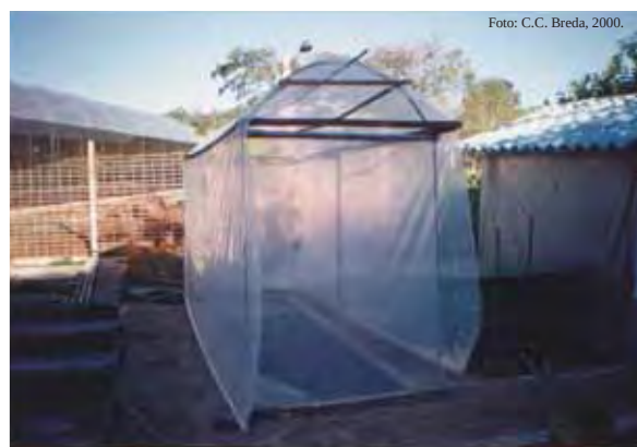
Figura 7: Terreiro de alvenaria protegido com túnel plástico para proteção e secagem final do lodo da ETL.
