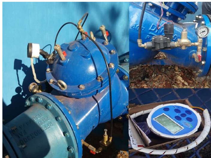
Figura 26 - VRP eletropneumática utilizada pelo SeMAE.
