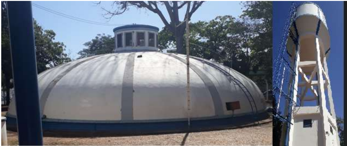
Figura 30 - Reservatório enterrado (esquerda) e elevado (direita) dos sistemas complementares de abastecimento.
