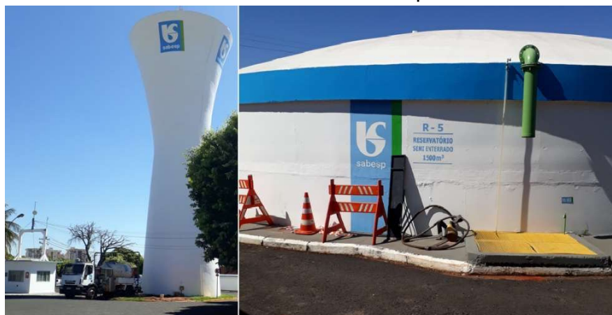
Figura 37 - Reservatório elevado (esquerda) e reservatório semi-enterrado (direita) da SABESP de Fernandópolis
