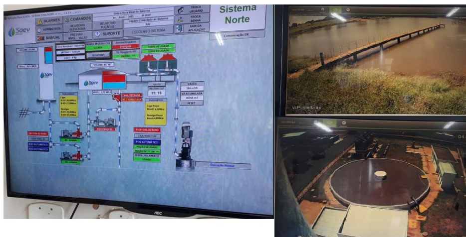
Figura 35 - Sistema de telemetria e monitoramento dos poços tubulares e do manancial de Votuporanga
