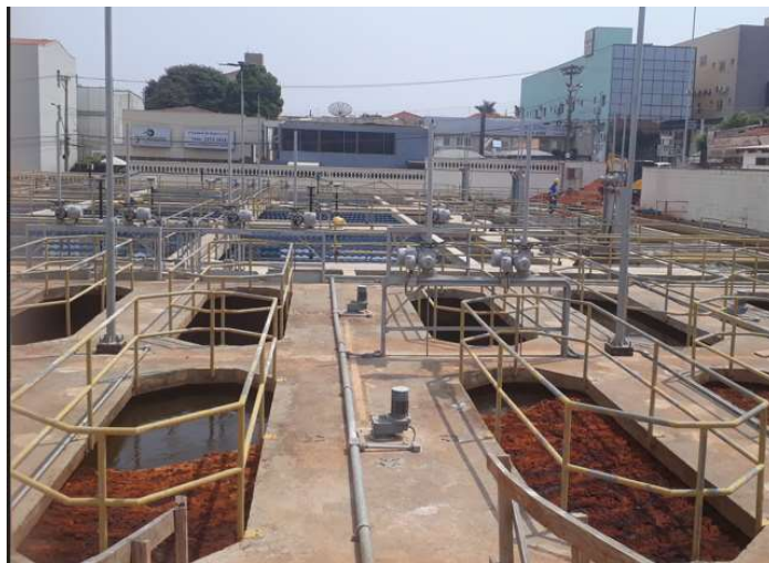
Figura 31 - Estação de Tratamento de Água "Palácio das Águas"
