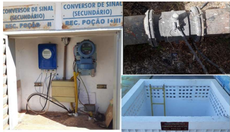
Figura 42 - Conversores de sinal (esquerda) e macromedidor eletromagnético e sua identificação (direita) utilizado pela SABESP
