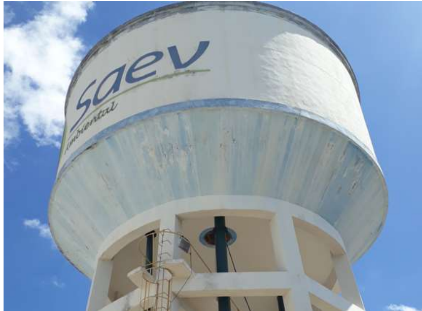
Figura 32 - Reservatório elevado da região Central de Votuporanga
