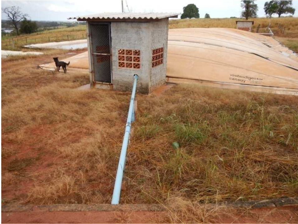
FIGURA 3.9 - Condução de dejetos pós diluição até o biodigestor Fonte: Elaborado pelo autor.
