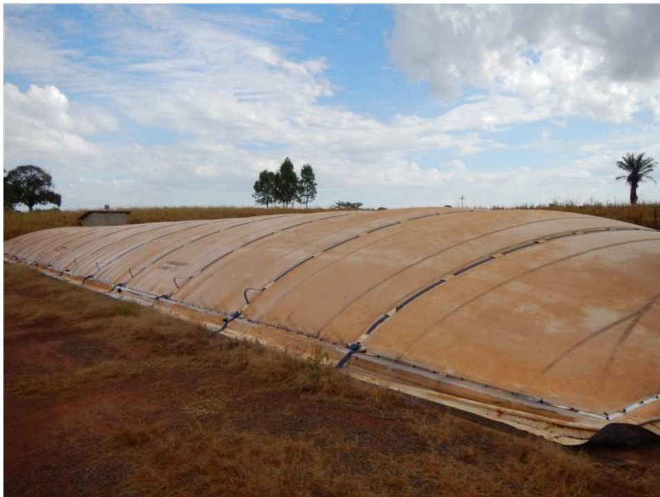
FIGURA 3.10 - Biodigestor modelo Canadense. Fonte: Elaborado pelo autor.
