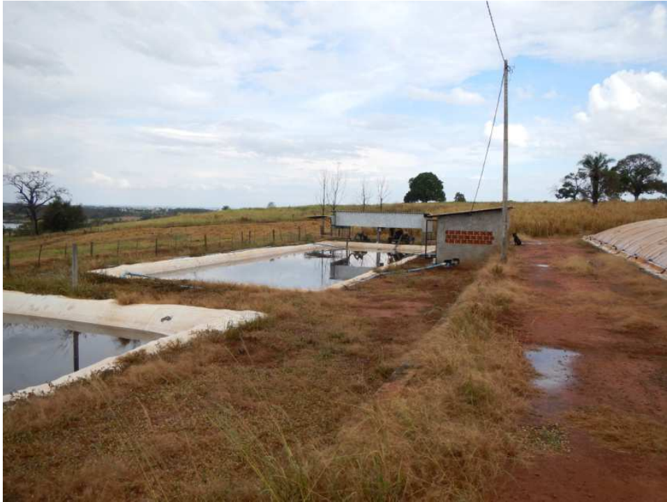
FIGURA 3.11 - Lagoa aeróbica utilizada para a fertirrigação. Fonte: Elaborado pelo autor.
