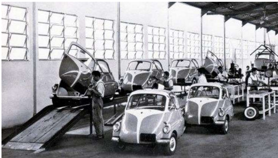
Figura 02 – Linha de produção do Romi-Isetta em Santa Bárbara D'Oeste (SP).
