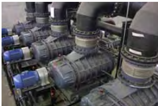
Figura 27: Bombas de lóbulos (Ewards, 2012a).
