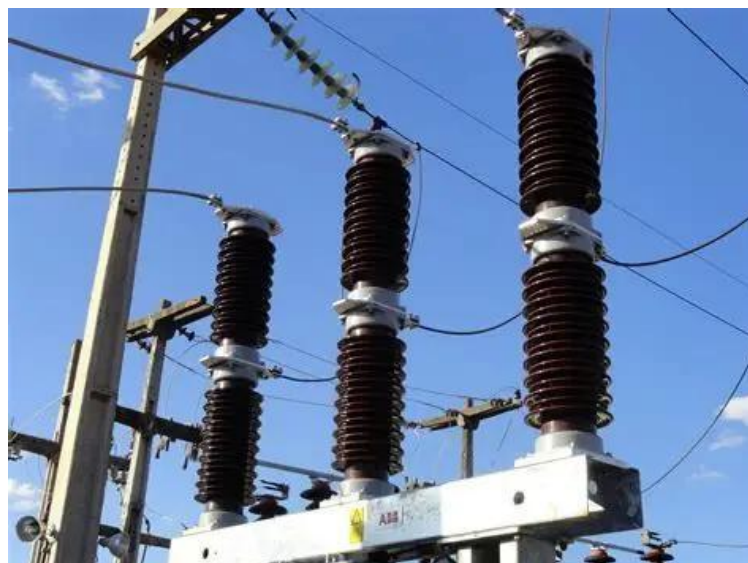
Figura 2 – Disjuntor 69kV
