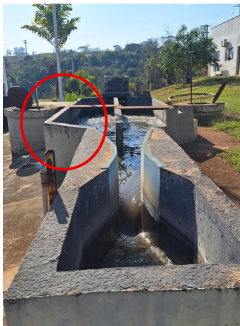
Figura 3. Calha parshal do DAE Bauru – Ponto 1 (coletas feitas na área destacada pelo círculo vermelho). Fonte: Arquivo pessoal.
