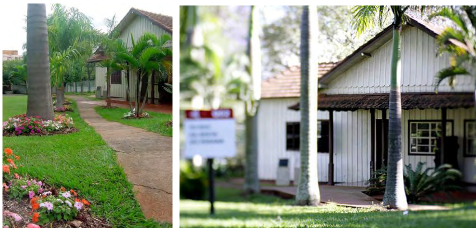
Figura 26 – MBP antes, sem rampa de acesso, e depois, com a rampa de acesso para cadeirantes.
